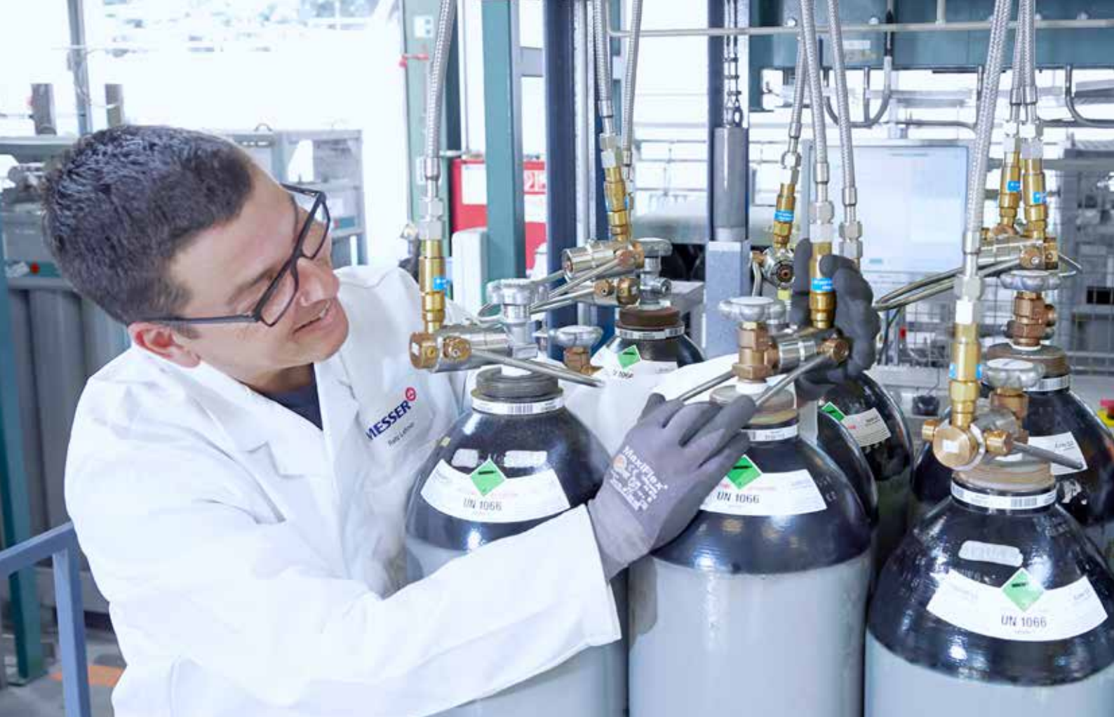
Station de remplissage pour gaz purs en Lenzburg
